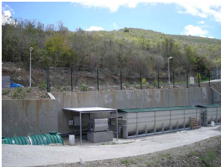
La mini station d'épuration du morne O'Reilly
