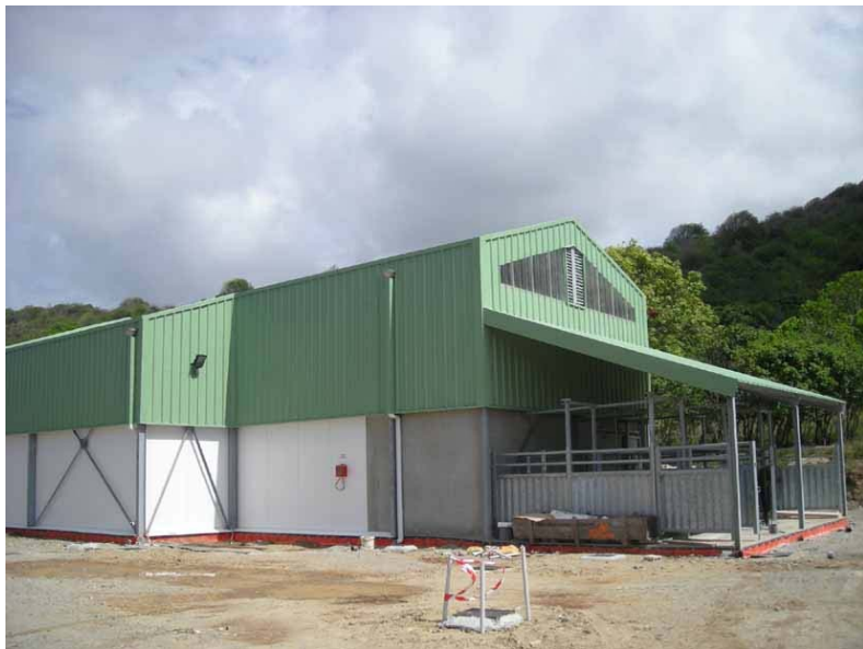
L'abattoir en construction. Il est situé le long de la la N7 qui longe l'aéroport de Grand Case, au pied du Milrum.
